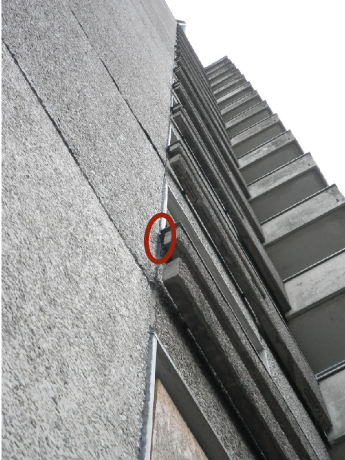
Bild 3: Spaltquartier für Fledermäuse hinter den Betonplatten
