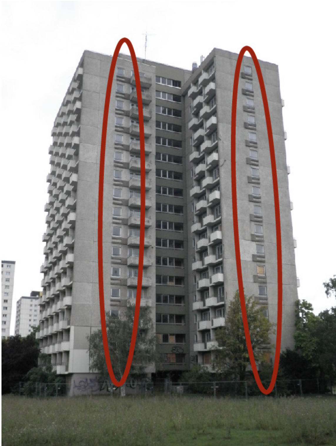
Bild 4: Bereiche, in denen die Alu-Abdeckungen zu beseitigen sind (4 x 2 x 16 Stück)
