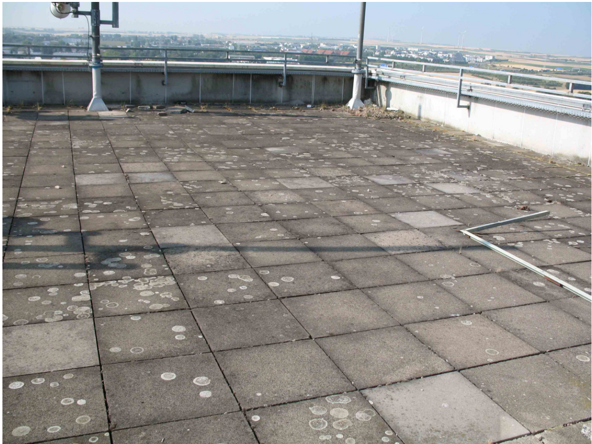
Bild 1: Flachdach ohne Spalten für Fledermäuse
