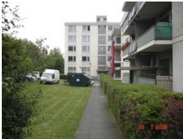
Foto 3: Ansicht nach Norden
