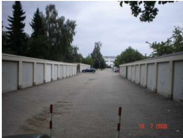
Foto 2: Verkehrsfläche mit Parkplätzen
