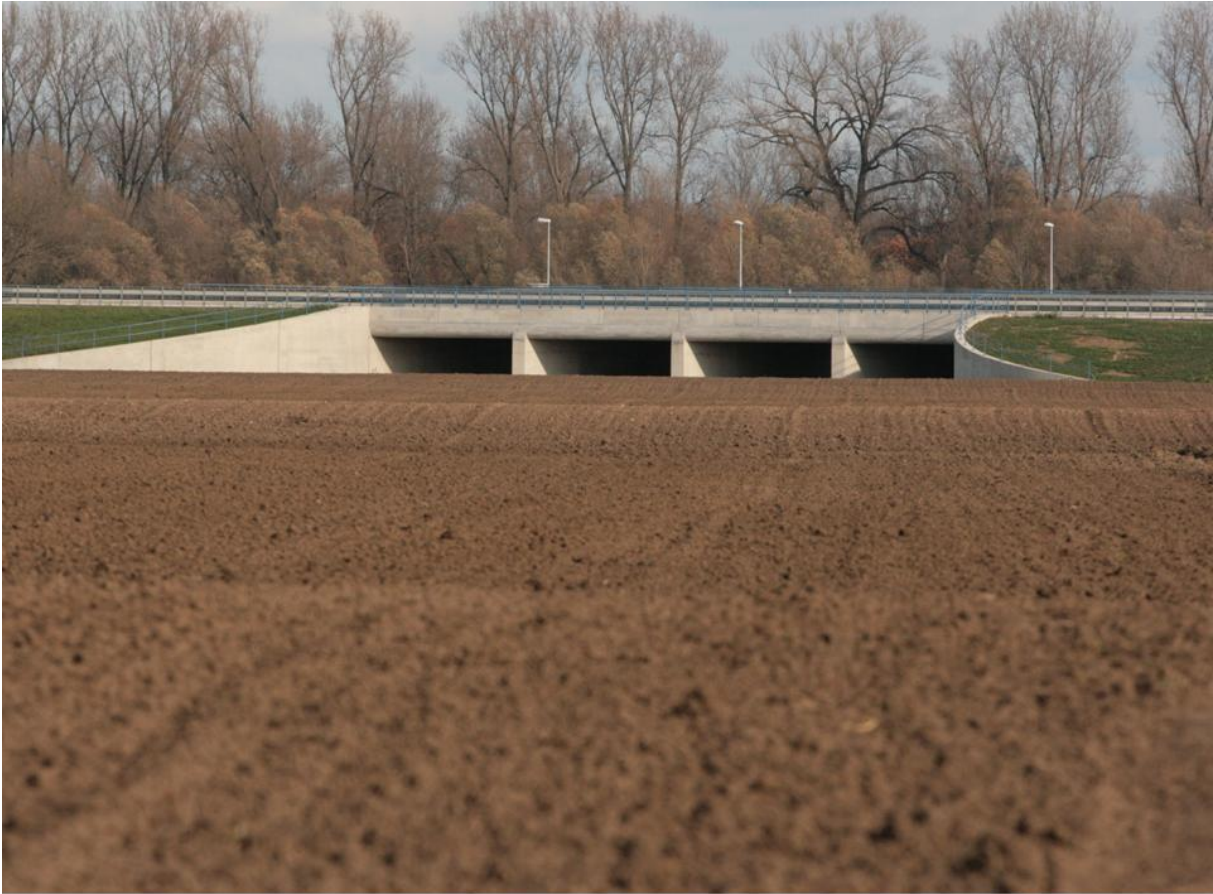
Rastfläche „RE“ Polder Laubenheim, Einlaßbauwerk
