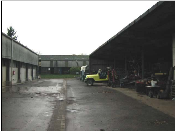
Abbildung 3: Blick vom Stallgebäude auf den Reitplatz und das Wohnhaus im Norden
