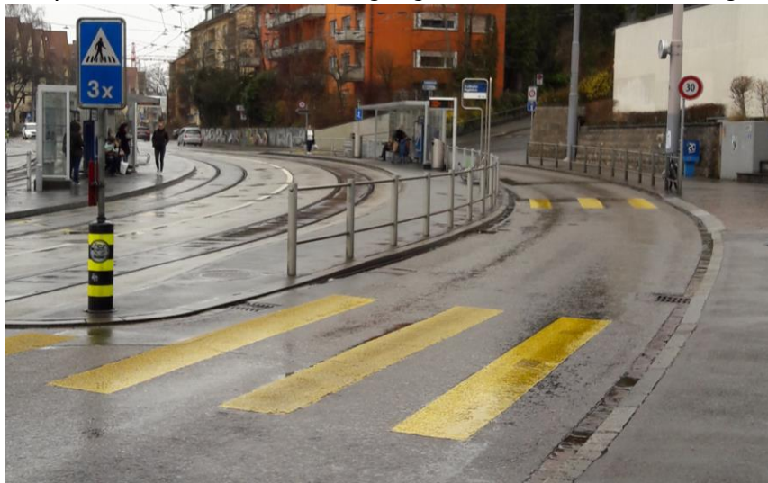
Beispiel Zürich: verbesserte Zugänglichkeit durch mehrere Zugänge in kurzem Abstand
