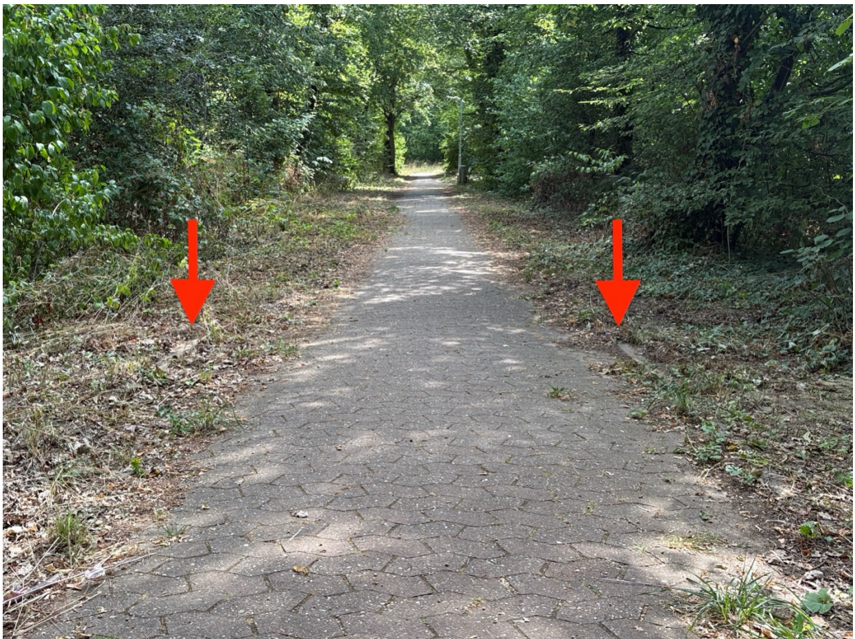
Befestigter Fußweg vom Bürgerhaus in Richtung Straßenbahn-Endhaltestelle, bzw. Ortsmitte/EKZ Die roten Pfeile markieren den Verlauf der Randsteine
