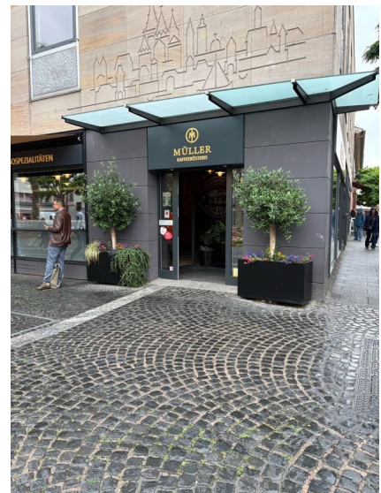
Abb. 24: Barrierefreie Gestaltung durch Stufenbeseitigung, Höfchen Hs.-Nr. 2 (© Landeshauptstadt Mainz)
