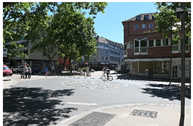
Abb. 7: Minikreisverkehr in der Große Langgasse nach Umgestaltung (© Landeshauptstadt Mainz)
