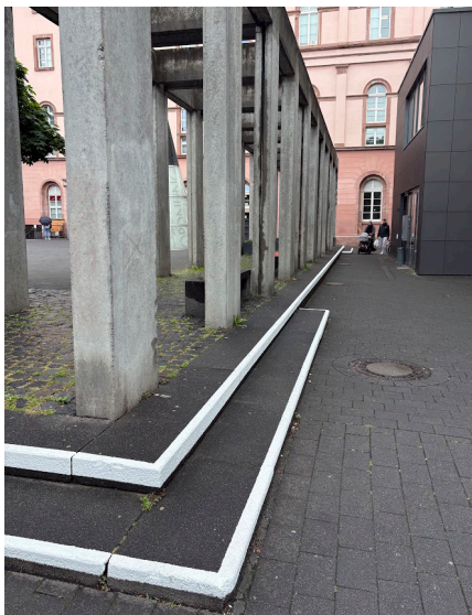
Abb. 22: Markierungen und Regulierung von Treppenstufen im Bereich Tritonplatz / Betzelsstraße (© Landeshauptstadt Mainz)
