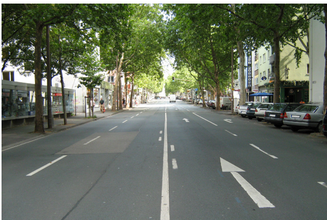
Abb. 6: Große Langgasse vor der Umgestaltung (© Landeshauptstadt Mainz)
