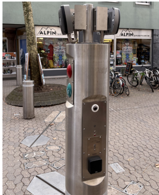
Abb. 30: Anlage Fischtor, lokale Bedieneinheit (© Landeshauptstadt Mainz)
