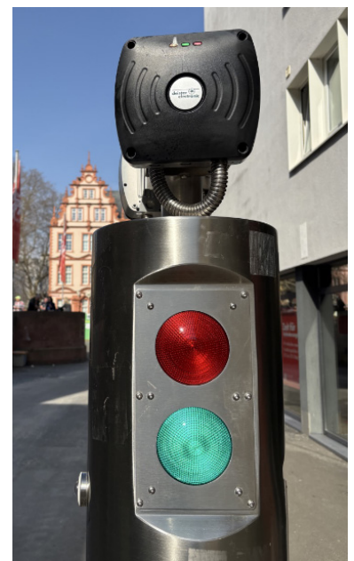
Abb. 31: Anlage Liebfrauenstraße, RFID-Antenne (Weitbereichsleser) (© Landeshauptstadt Mainz)
