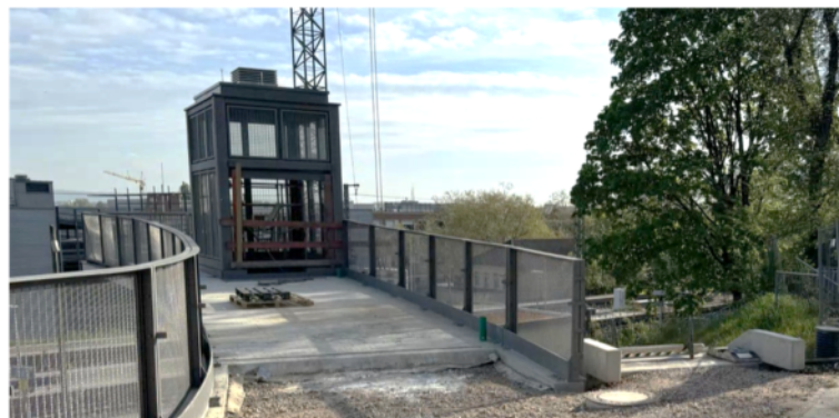
Aufzugsschacht mit Galerie, während der Bauphase 2025
