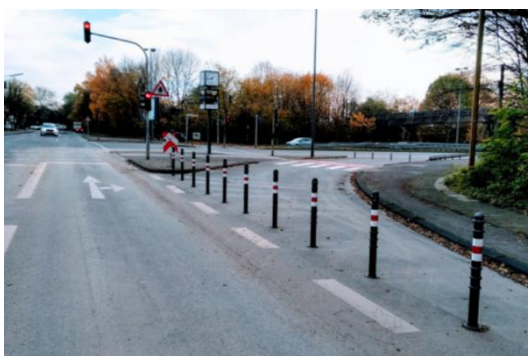
Abb. 8-5: Mit einfachen Mitteln aus der Nutzung genommener freier Rechtsabbieger in Köln 47
