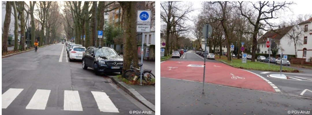
Abb. 3-17: Fahrradstraßen in Mainz (links: neue Fahrradstraßen Hindenburgstraße, gestaltet nach Mainzer Standard für Fahrradstraßen; rechts: Hechtsheim-Radroute am Übergang von Drususwall zur Fahrradstraße Neumannstraße)
