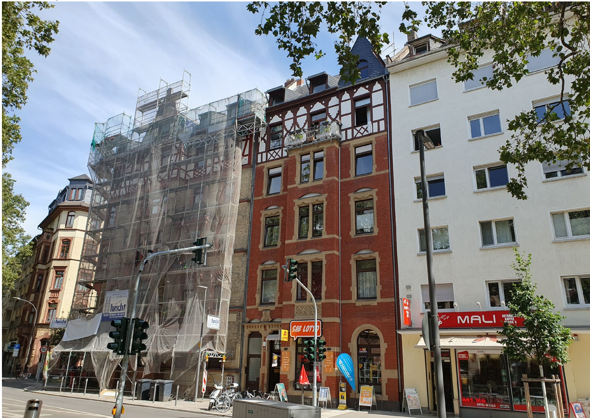
Abbildung 10: Unterschiedliche Baualtersklassen und Fassadenzustände sowie Einzelhandel
