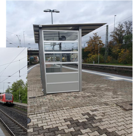
WSH am Bahnsteig 2/3
