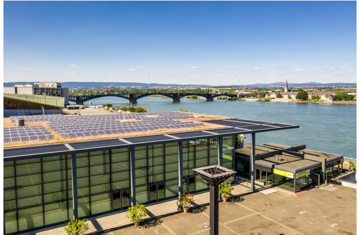
Photovoltaikanlage auf der Rheingoldhalle in Mainz. © mainzplus
