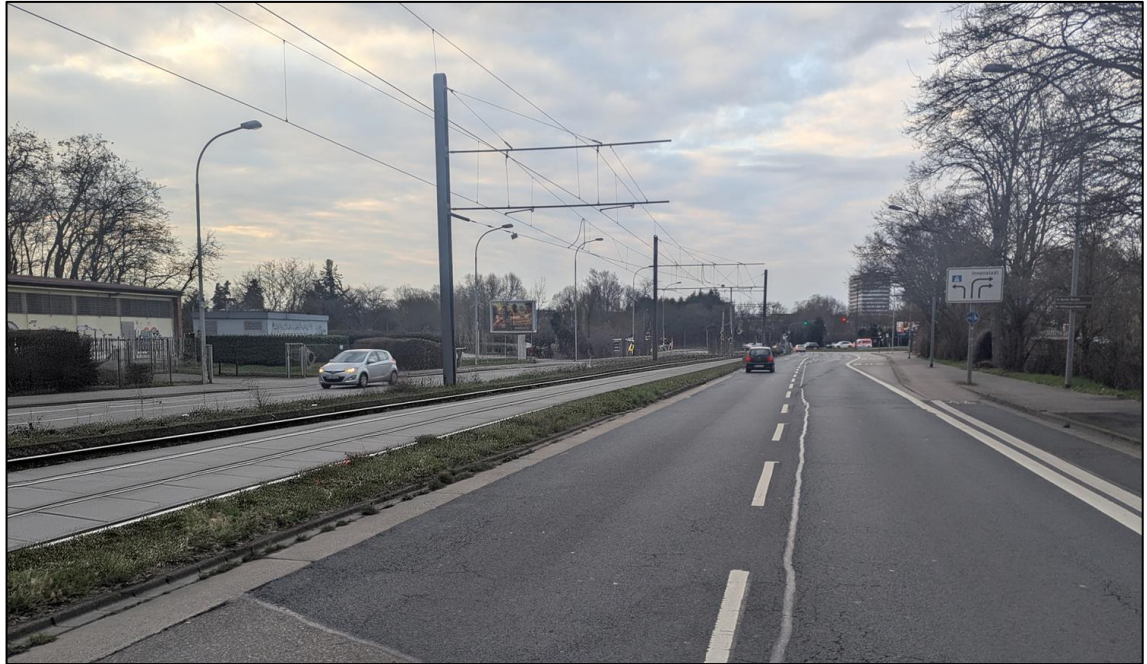
Abbildung 17: Umbau des Straßenbahngleiskörpers zur Mitnutzung durch Busse [Fotomontage]
