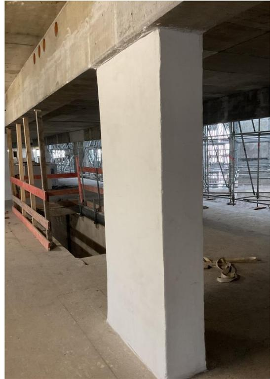
Abbildung 24: Betonsanierung Innenstütze
