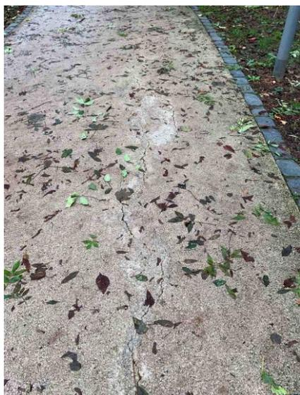
Abbildung 13: Gefärbte Asphaltoberfläche mit ver-gossenen Rissen, die wieder durchgeschlagen sind
