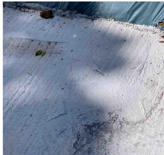
Abbildung 8: Riss und entmischte Betonoberfläche vom Fundament
