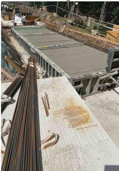
Abbildung 7: Fertig betoniertes Fundament unter Sonneneinstrahlung
