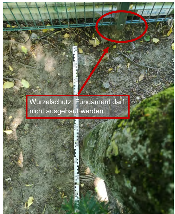
S6, Zaun wird abgebaut, Fundament verbleibt
