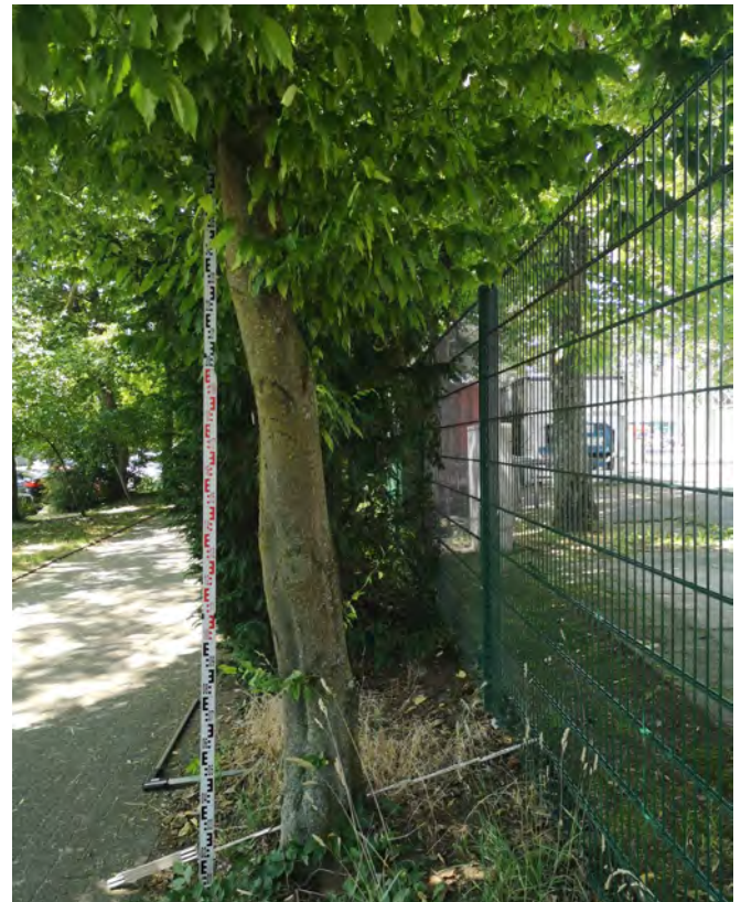
S4, Zaun wird abgebaut
