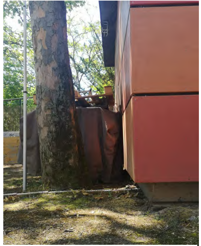
31, Standort sehr nahe an einem Streifenfundament
