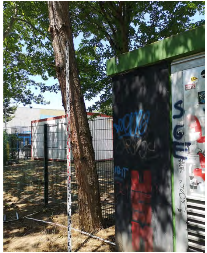
S10, Stabgitterzaun wird abgebaut
