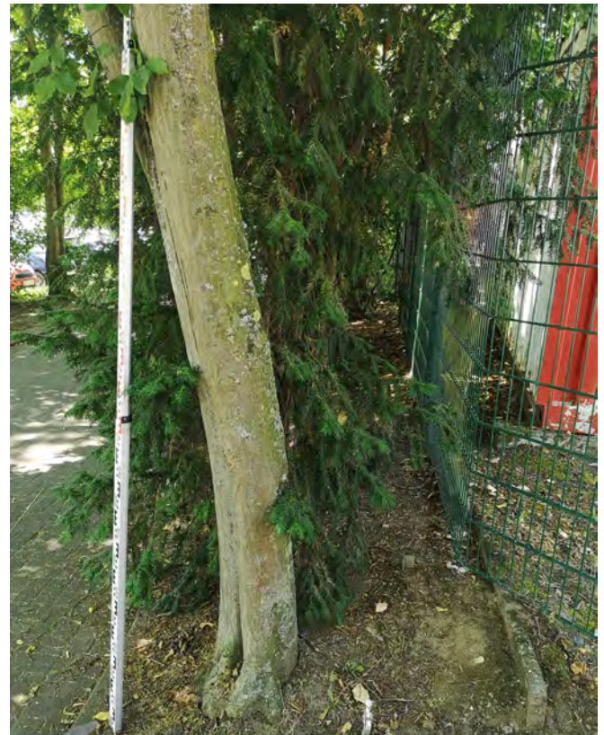
S5, Zaun und Toranlage werden abgebaut
