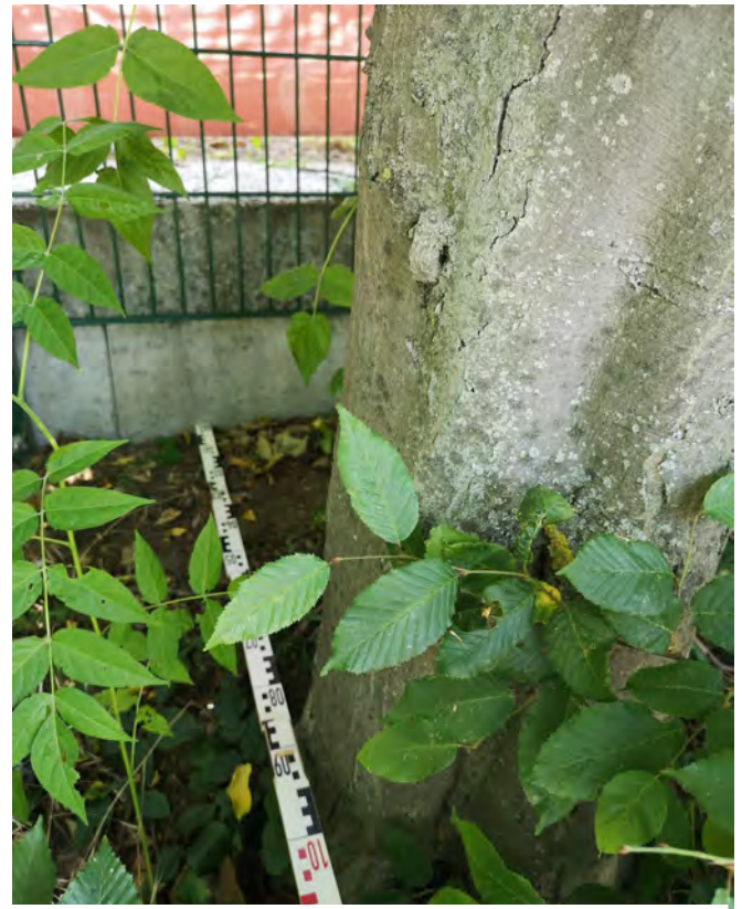
S3, L-Steinmauer verbleibt, Zaun wird abgebaut
