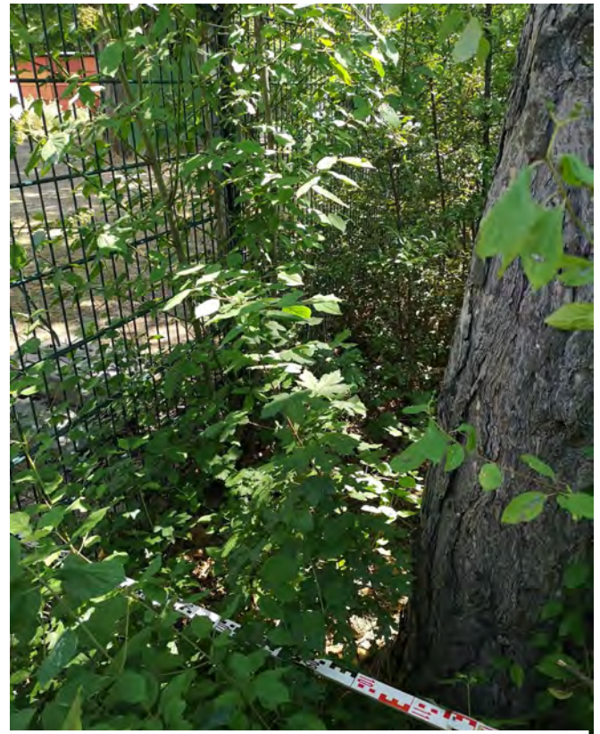
S14, Stabgitterzaun wird abgebaut
