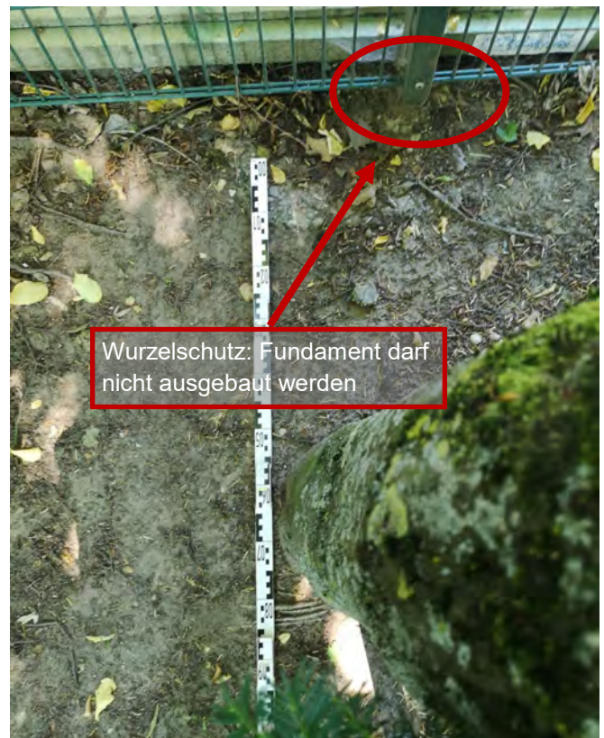
S6, Zaun wird abgebaut, Fundament verbleibt
