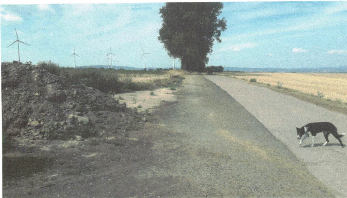
Abb. 7: Ausgleichfläche Ebersheim, Zustand vor Entsiegelung, Begehung 30.07.2022
