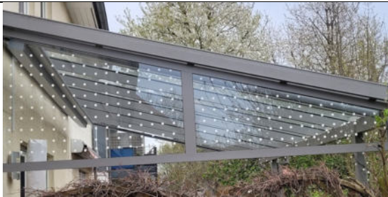
2. Nachrüstung durch Folie, Terasse in Hechtsheim
