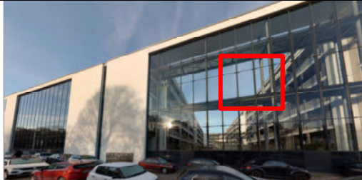
1. Positives Beispiel, Lärmschutzwand Studentenwohnheim Mombacher Straße
