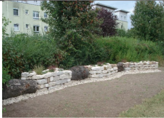
5. Anlage einer Trockenmauer
