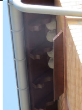
2.Ersatznisthilfen nach Sanierung
