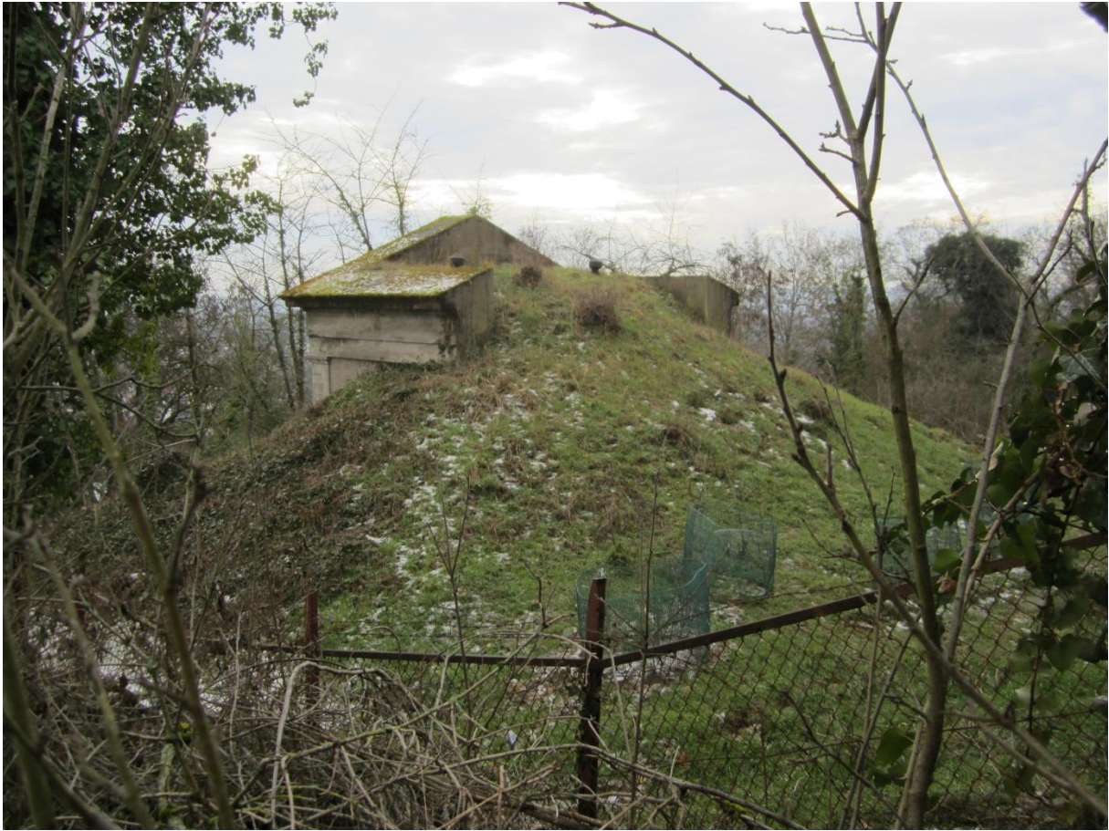
Erdbedecktes Wasserreservoir, Foto 2021
