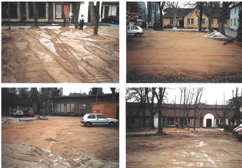
Foto 1: Bilder von der Rückverfüllung im Rahmen der Sanierung 1999, mit gesiebtem Sand aus der Kiesgrube Weilbach
