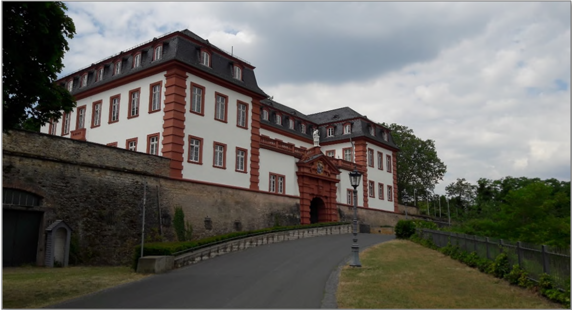
Abbildung 14: Kommandantenbau – Gebäude A.
