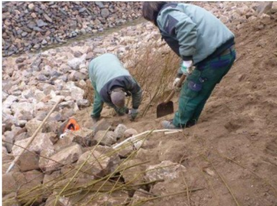
(5) Einbau der Heckenlagen in die ausgehobenen Pflanzgräben; Ende Nov. 2011
