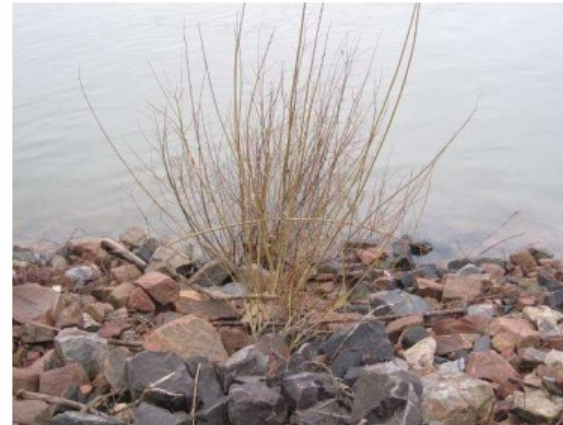
(6) Pflanzgraben mit einjährigen Busch- und Heckenlagen; Jan. 2013
