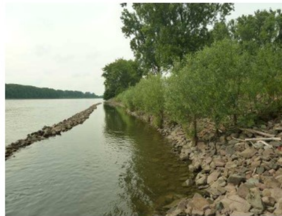
(12) Weidensetzstangen 2 ½ Jahre nach Bau fertigstellung; Mai 2014
