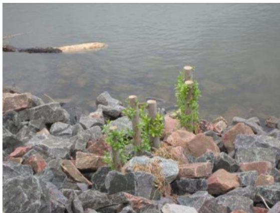
(7) Voranschreitende Entwicklung der Weiden-setzstangen; April 2012
