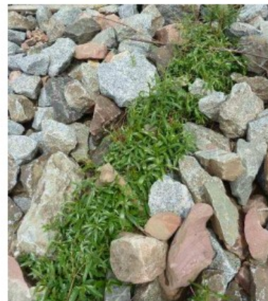
(8) Ausgetriebene Weidenfaschinen; Ende April 2012
