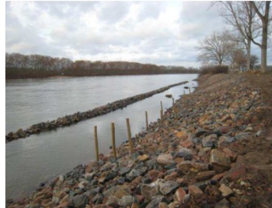
(2) In die Pflanzgräben eingebaute Weidensetzstangen; Dez. 2011
