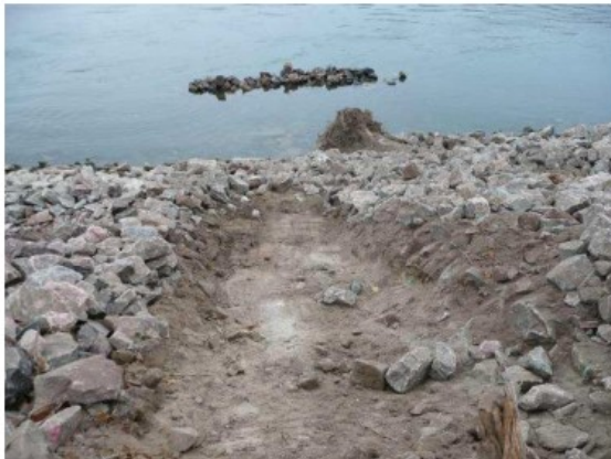
(1) Aushub eines Pflanzgrabens im Deckwerk aus losen Wasserbausteinen bis zum anstehenden Boden; Nov. 2011
