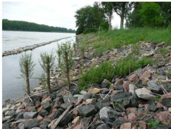
(9) Voranschreitende Entwicklung der begrünten Steinschüttung; Juni 2012
