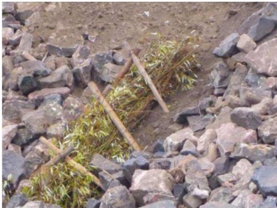
(3) In die Gräben eingelegte und verpflochte Weidenfaschinen; Ende Nov. 2011
