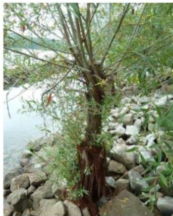
(11) Weidensetzstange mit ausgebildeten Luftwurzeln (Adventivwurzeln); Aug. 2013
