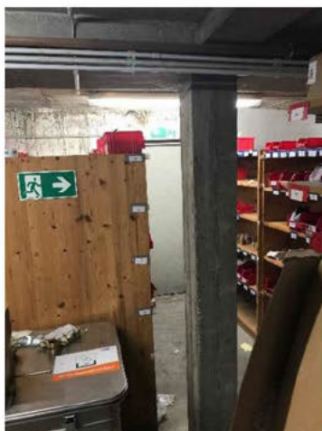
Fluchtweg mit Betonstütze
