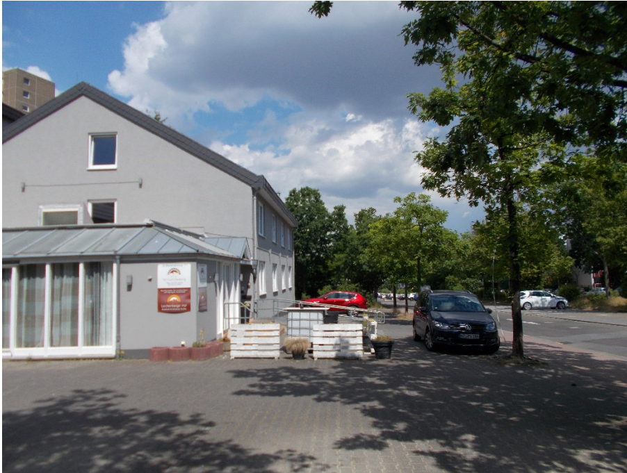
Abbildung 3: Blick auf die Hotelanlage mit Stellflächen (Quelle: Stadt Mainz, 2023)
