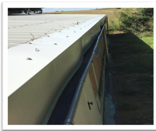
Abbildung 7: Ausführung Dachrandprofil
