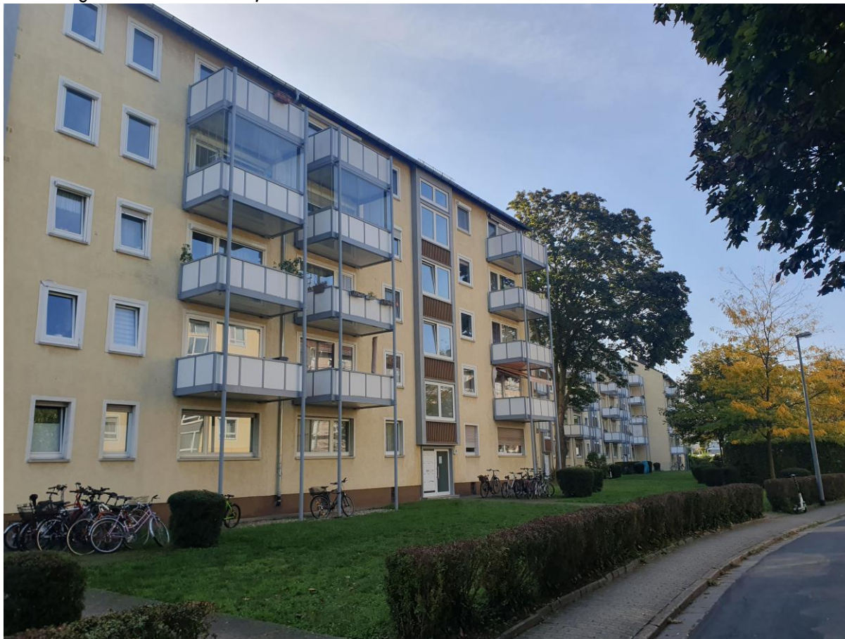
Abbildung 13: MZ-Oberstadt, neue Balkone
