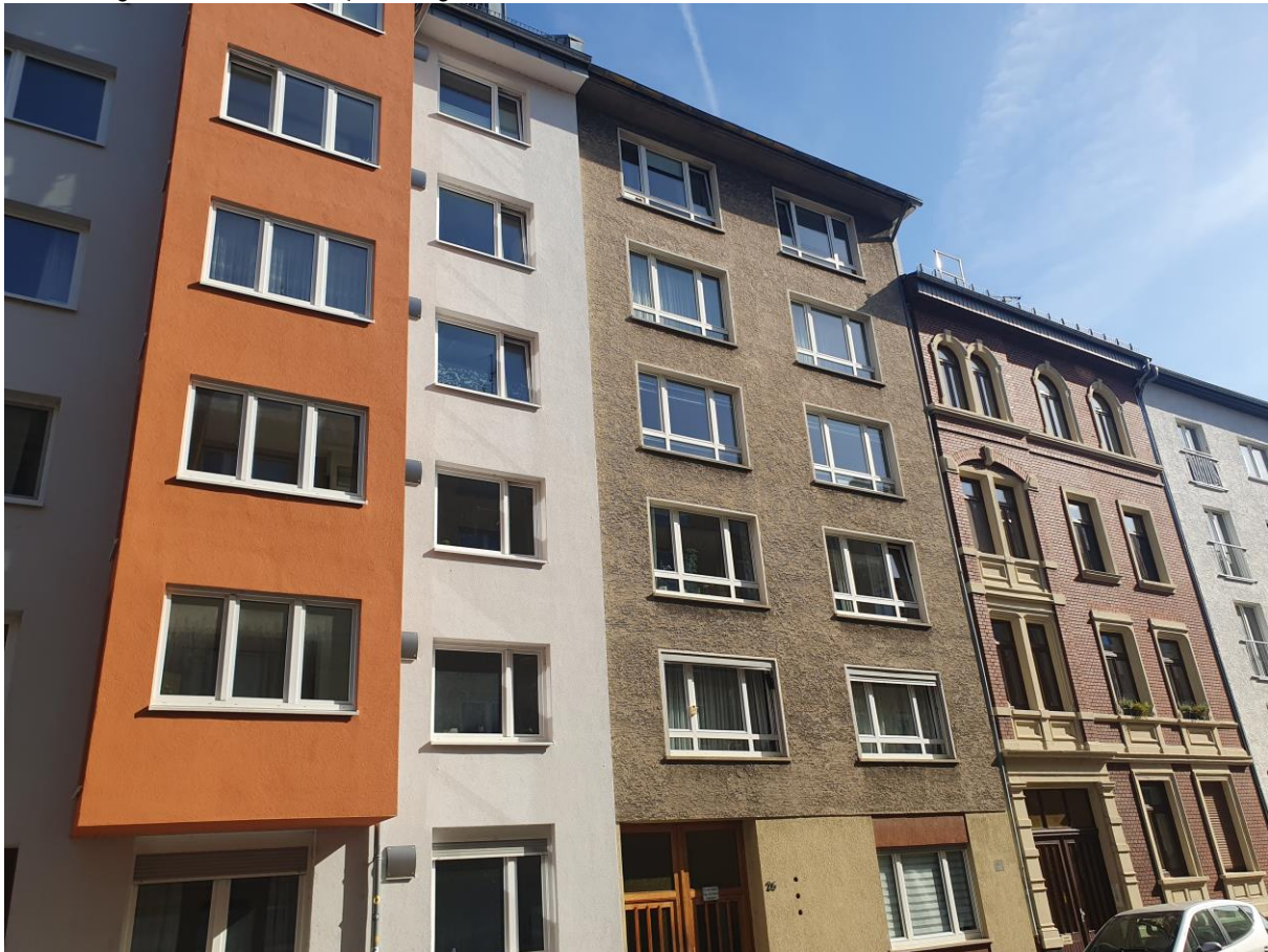
Abbildung 11: MZ-Altstadt, Wohngebäude aus unterschiedlichen Bauklassen
