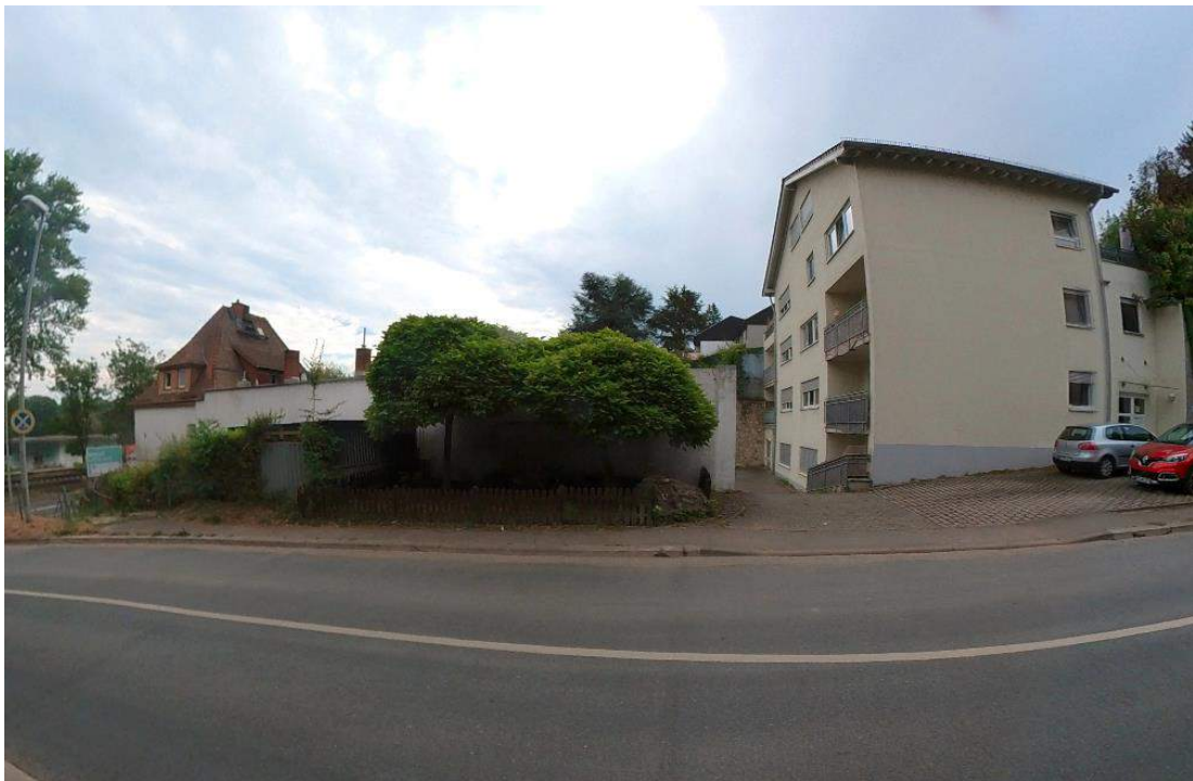
Bild 28: Wohnanlage an der Einmündung der Dr. Friedrich-Kirchhoff-Straße in die Wormser Straße
