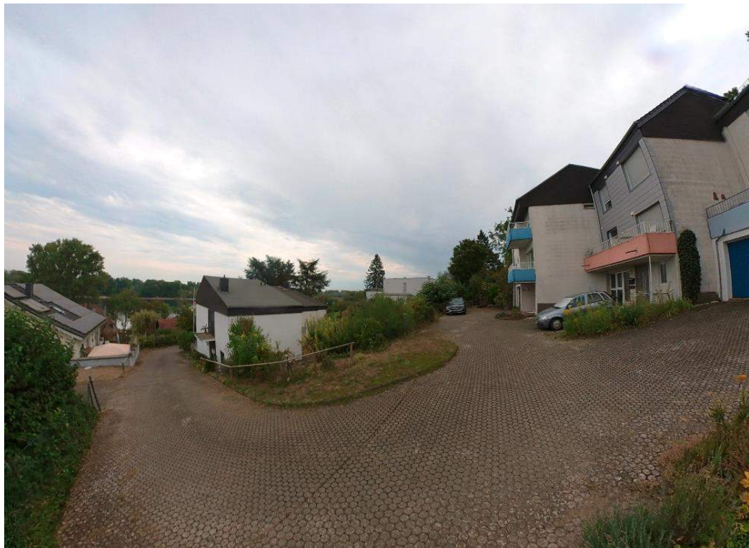
Bild 34: Blick auf die Häuser Wormser Straße 171A bis 171F und den Rhein
