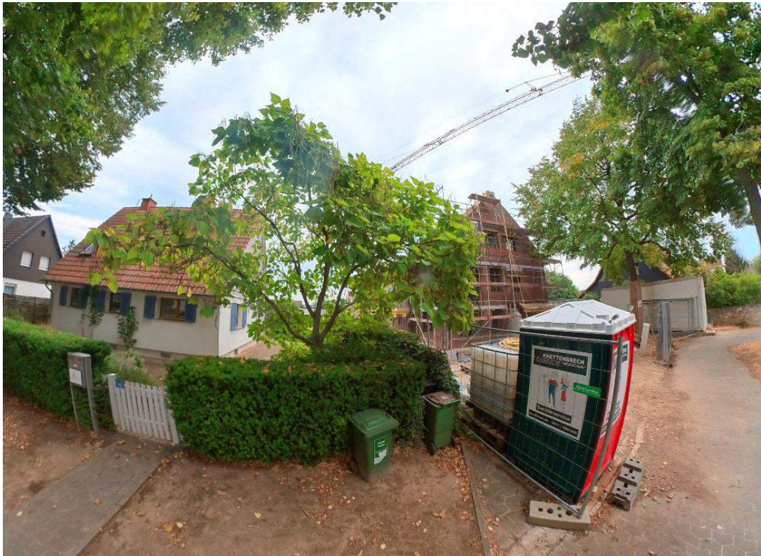
Bild 13: An mehreren Stellen im Plangebiet entstehen neue Gebäude
