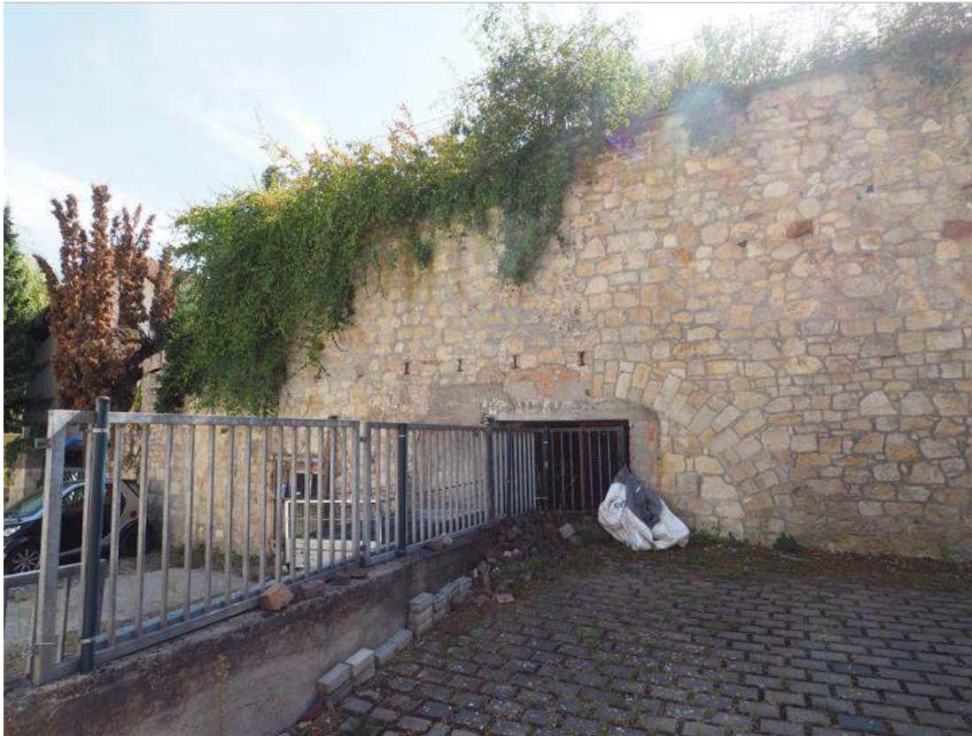
Bild 29: Kellereingang mit Potenzial als Quartier für Fledermäuse in der Wormser Straße 169
