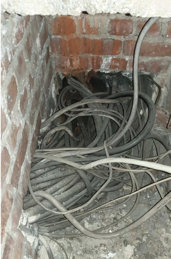
Foto 3: Intensive Kabelführung im Schacht
