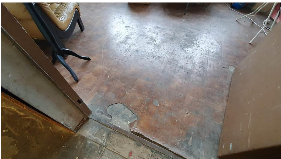
Foto 99: Cushion-Vinyl-Bodenbelag im südlichen Lagerraum
