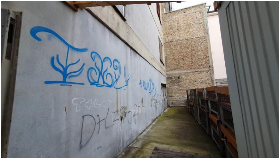
Foto 4: Südliche Fassade: verputzter Teil der Fassade
