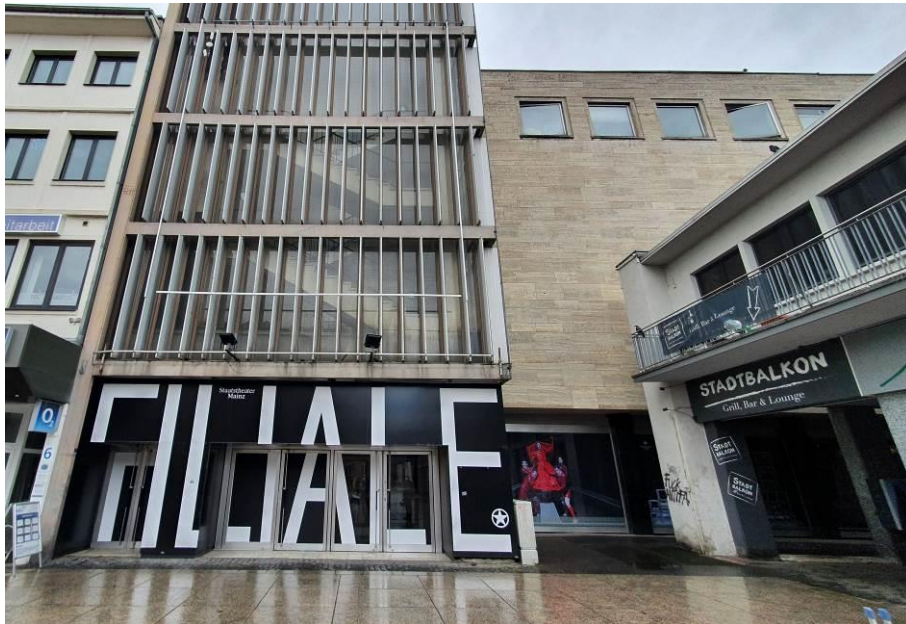
Foto 1: Nördliche Fassade: Glas- und Naturstein
