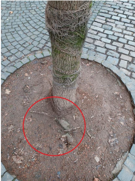
Abb. 38: Eppichmauergasse, Baum 14. Rindenschäden Wurzel.
