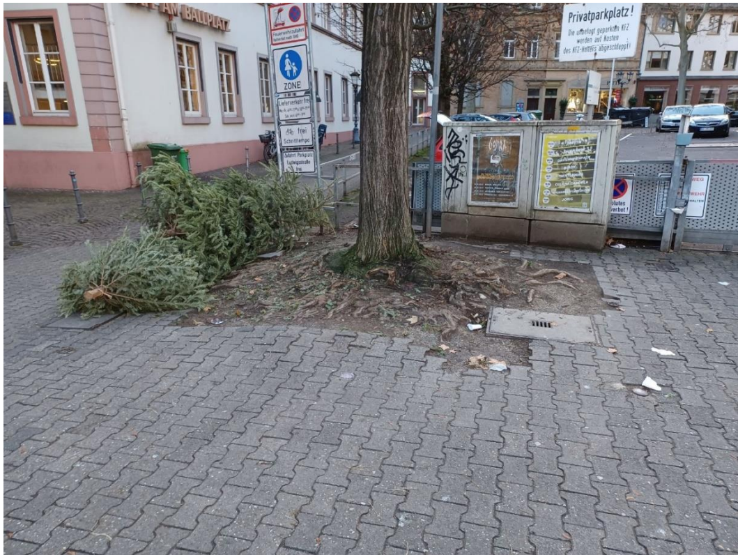
Abb. 47: Weißliliegasse, Baum 16. Baumumfeld mit offenliegenden Wurzeln und Bodenaufwölbungen.
