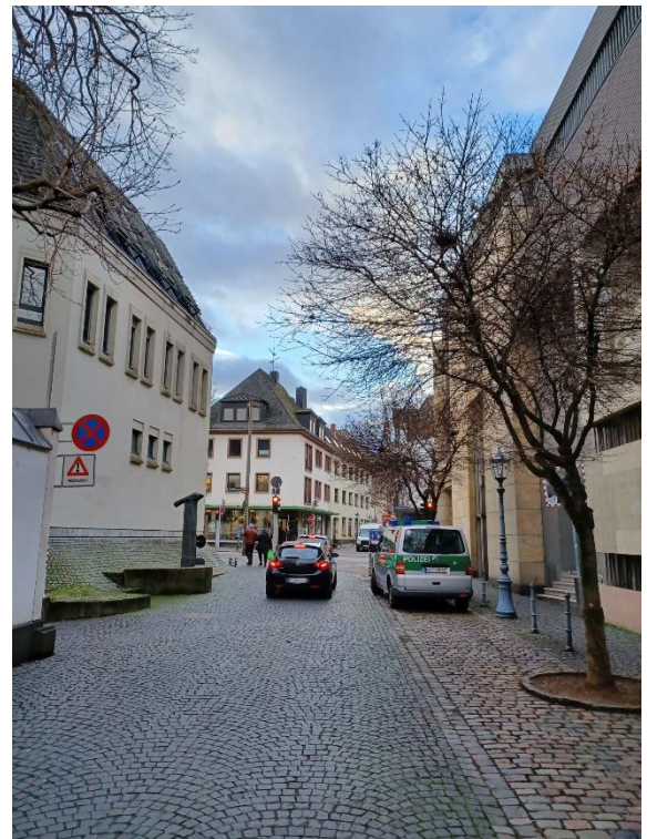
Abb. 41: Eppichmauergasse. Mangelndes Lichtraumprofil.
