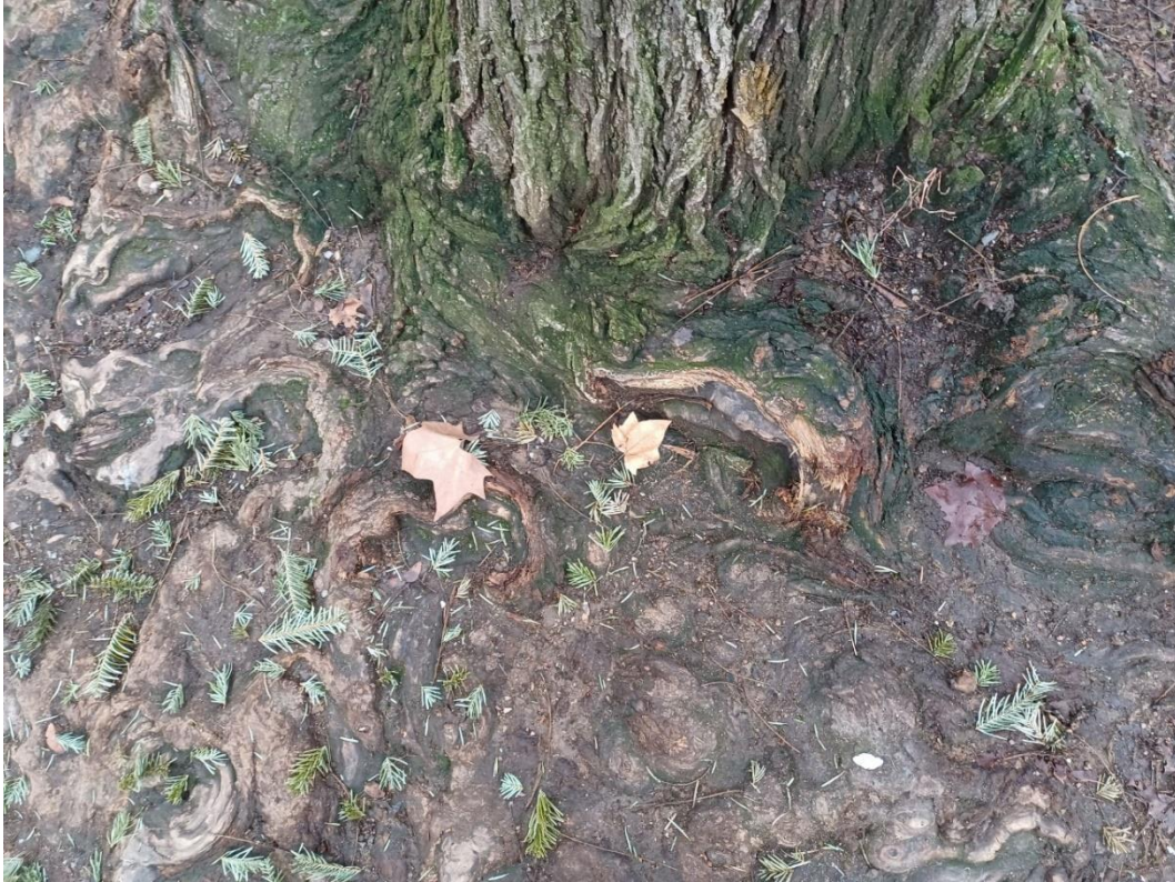
Abb. 49: Weißliliegasse, Baum 16. Rindenschäden Wurzel.
