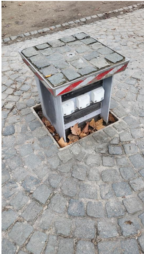
Bild 1: Defekter Stromanschluss
