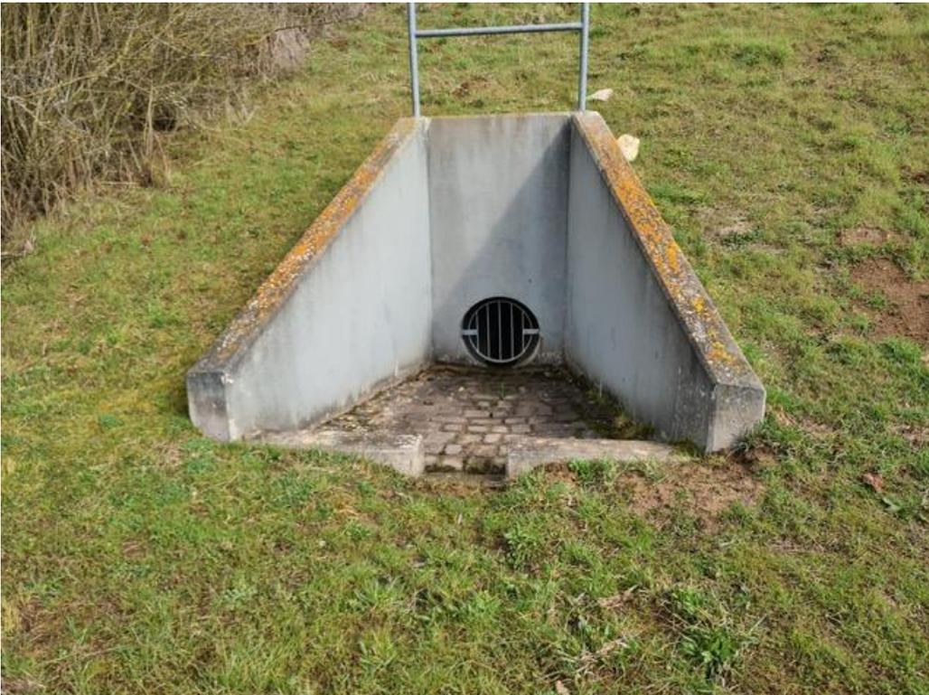
*Das Regenwasser wird nicht angestaut, sondern läuft nur durch das RRB*
