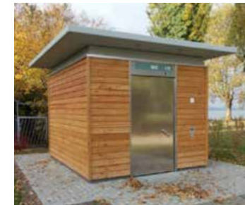
Holzfassade; umlaufendes Flachdach
