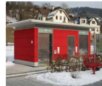
HPL-Fassade; umlaufendes Flachdach
