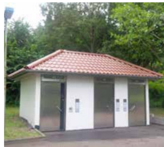
Putzfassade; Walmdach Pfanneneindeckung
