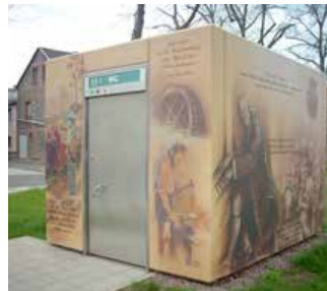
Betonfassade bedruckt; Flachdach
