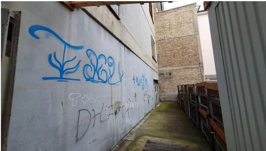
Foto 4: Südliche Fassade: verputzter Teil der Fassade
