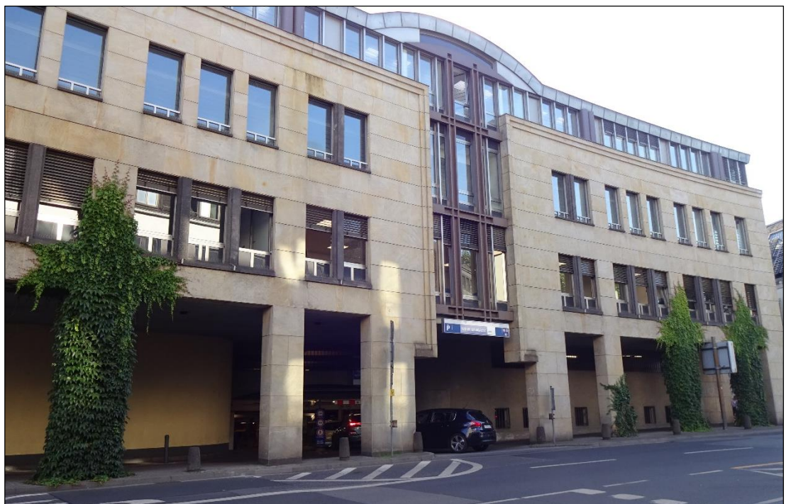
Abbildung 7: Fassadenbegrünung an der Deutschen Bank (Quelle: JESTAEDT + Partner, 2022)
