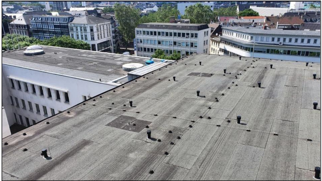
Abbildung 8: Dachfläche des Bestandsgebäudes an der Ludwigsstraße 12 (Quelle: Büro Gall, 2022)
