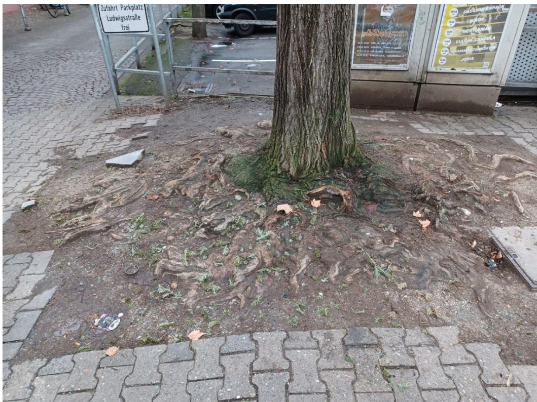
Abb. 48: Weißliliegasse, Baum 16. Rindenschäden an offenliegenden Wurzeln.
