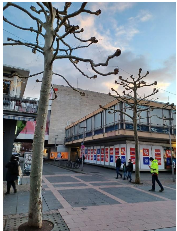
Abb. 60: Ludwigsstraße. Einfahrt Baustellenverkehr.
