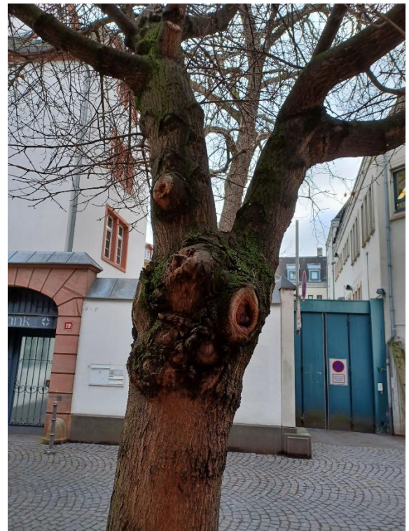
Abb. 37: Eppichmauergasse, Baum 14. Astungswunden mit Fäulnis.
