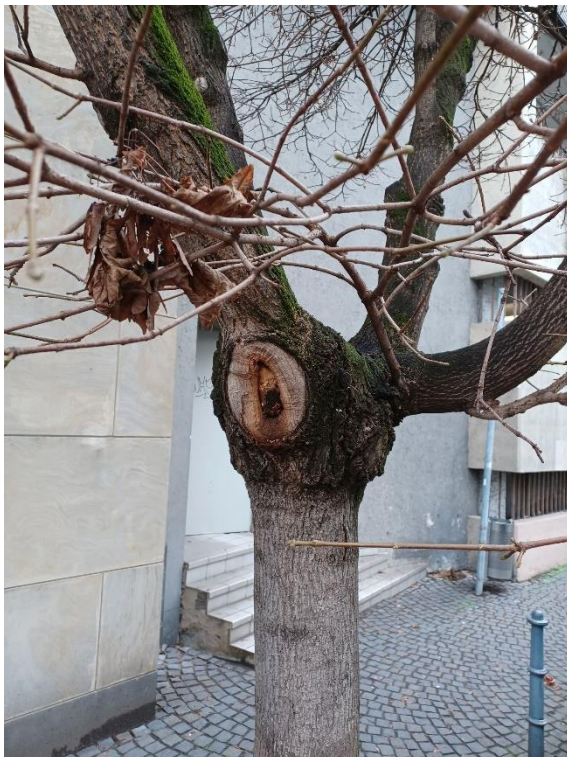
Abb. 40: Eppichmauergasse, Baum 15. Kappingsstelle mit Fäulnis.
