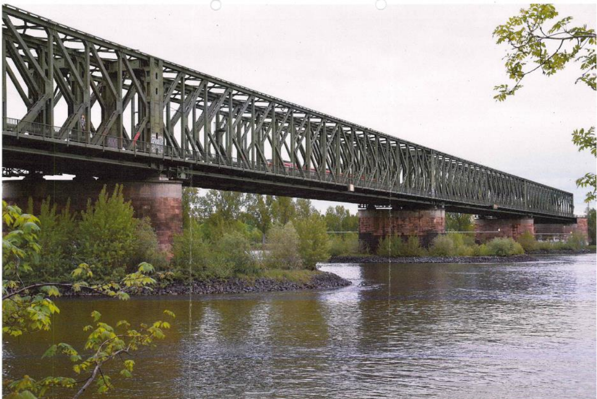
Stahlfachwerkkonstruktion Südbrücke von 1949
