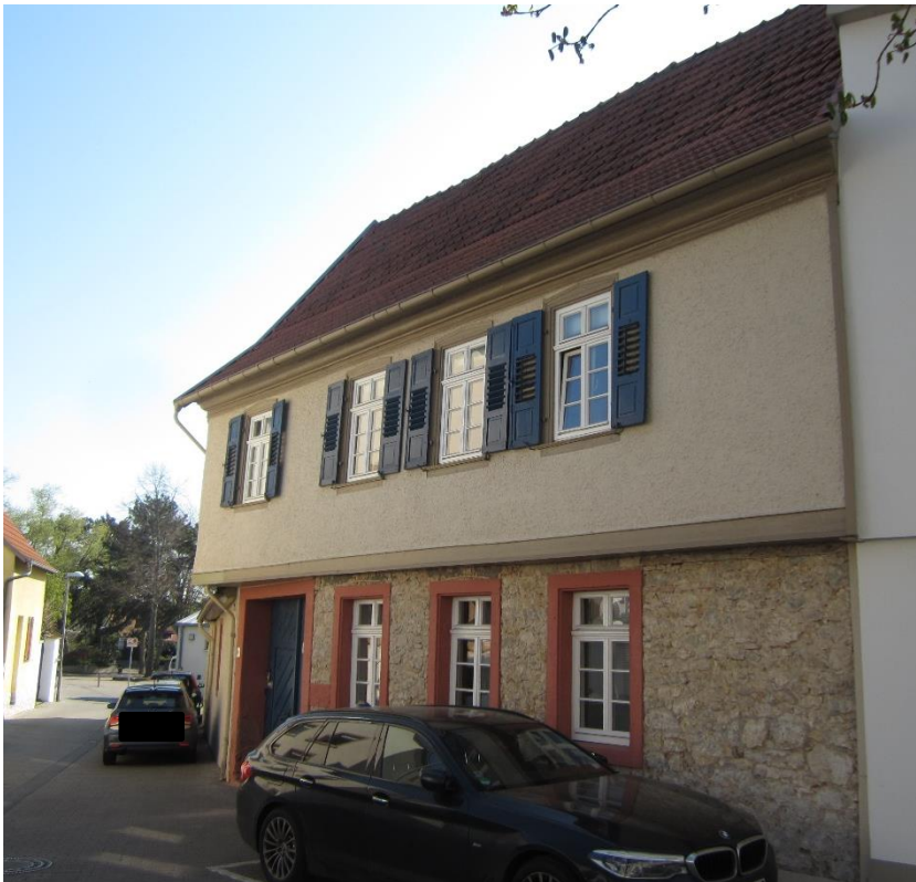
Wohnhaus Möhnstr. 20, Zustand 2020
