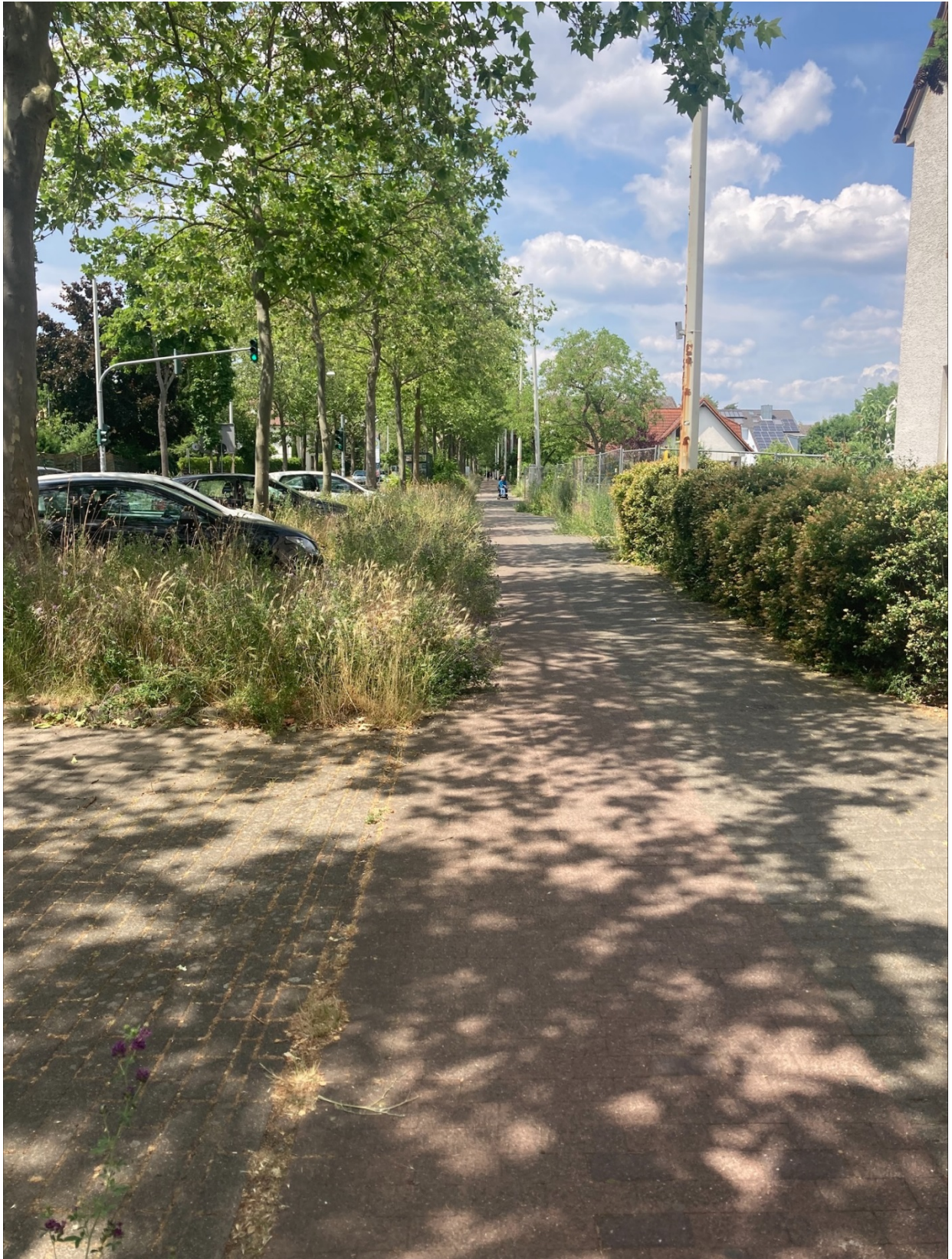
Fehlender Rückschnitt des Grüns an den Baumscheiben. Fahrradspur ist eingeschränkt nutzbar. Beispiel Straße an der Allee.
