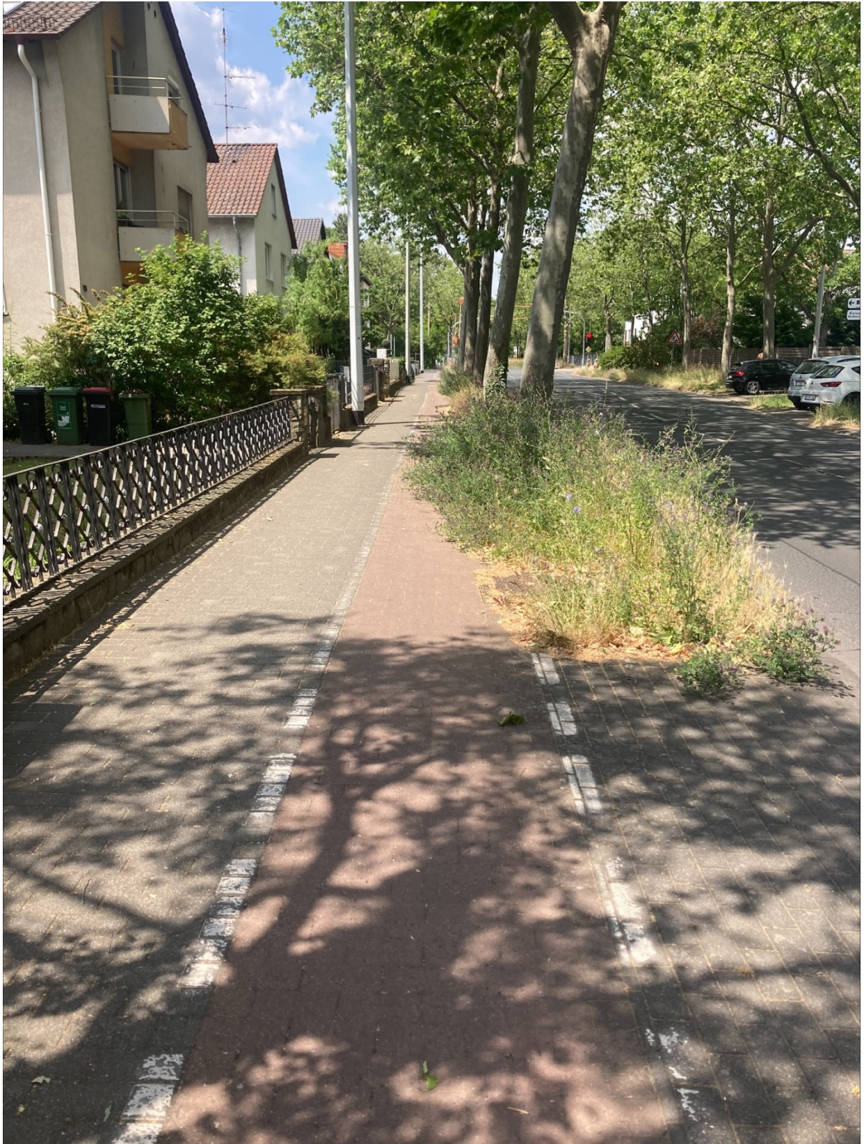
Fehlender Rückschnitt des Grüns an den Baumscheiben. Fahrradspur ist eingeschränkt nutzbar. Beispiel Straße an der Allee.
