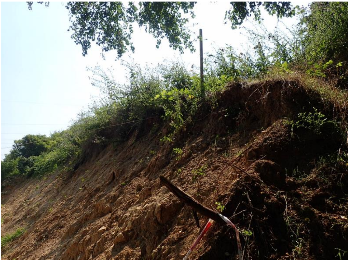
Bild 14: Der in die Umsiedlungsfläche ragende obere Teil der Mauerbaustelle*
