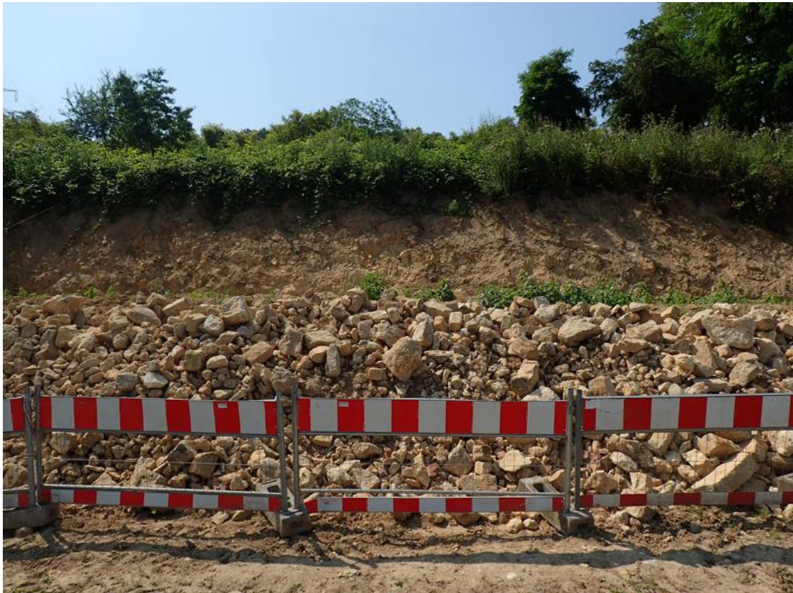
Bild 13: Trockenmauer-Baustelle im Nordosten der Umsiedlungsfläche*
