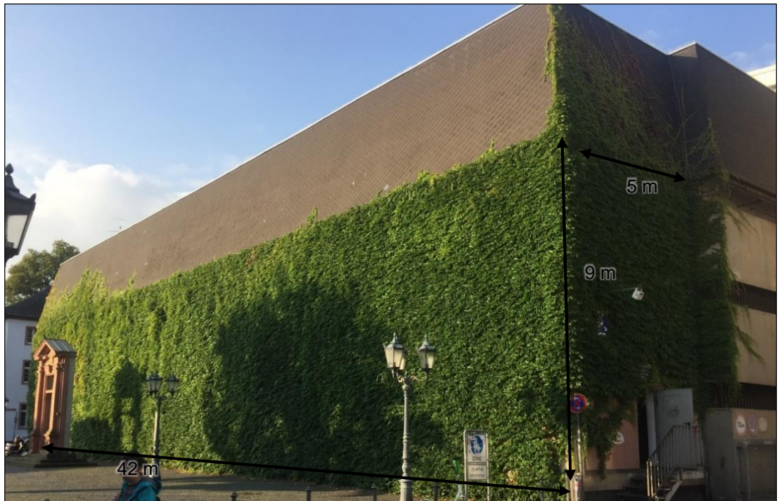
Abbildung 6: Fassadenbegrünung am Parkhaus (Quelle: JESTAEDT + Partner, 2021)
