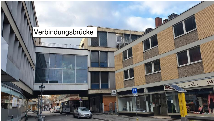
Foto 3: Südliche Fassade: verglaster Teil der Fassade
