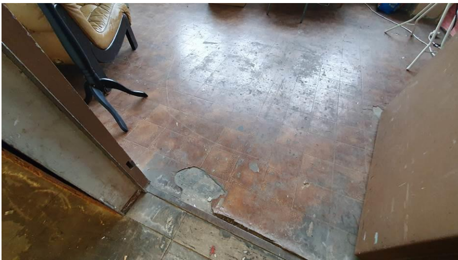
Foto 99: Cushion-Vinyl-Bodenbelag im südlichen Lagerraum
