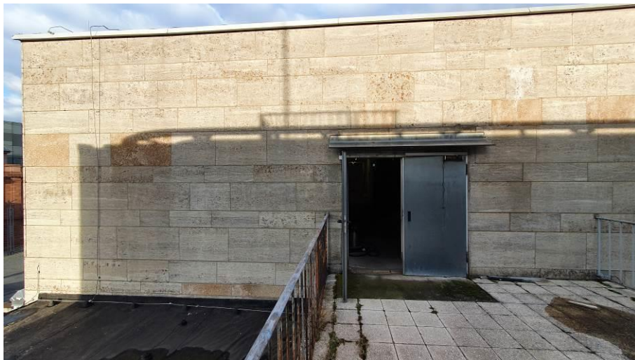
Foto 2: Westliche Fassaden aus Naturstein
