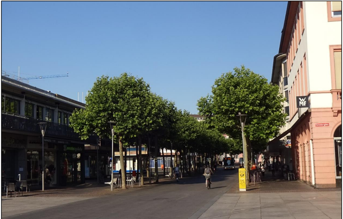
Abbildung 10: Blick vom Gutenbergplatz zum Schillerplatz (Quelle: JESTAEDT + Partner, 2022)
