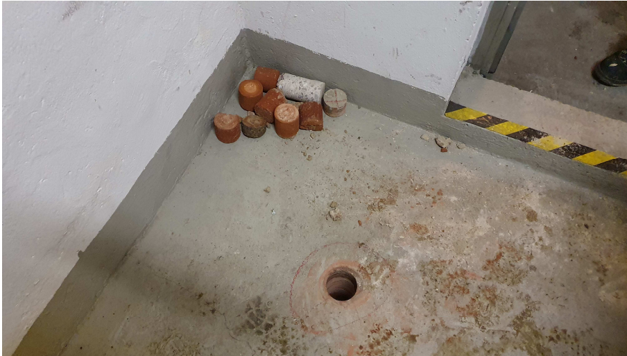
Foto 1: Erkundungspunkt RKS-BL 5 im Dieselraum
