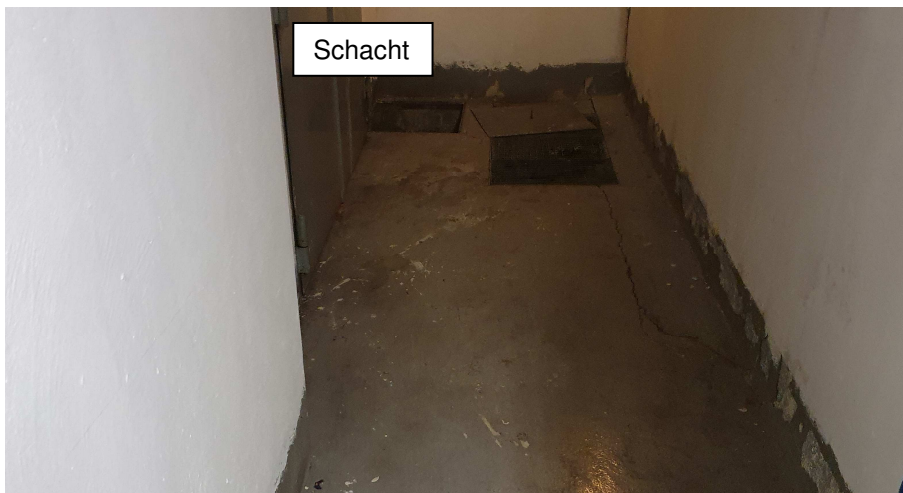
Foto 2: Schacht im Flur neben dem „Dieselraum“
