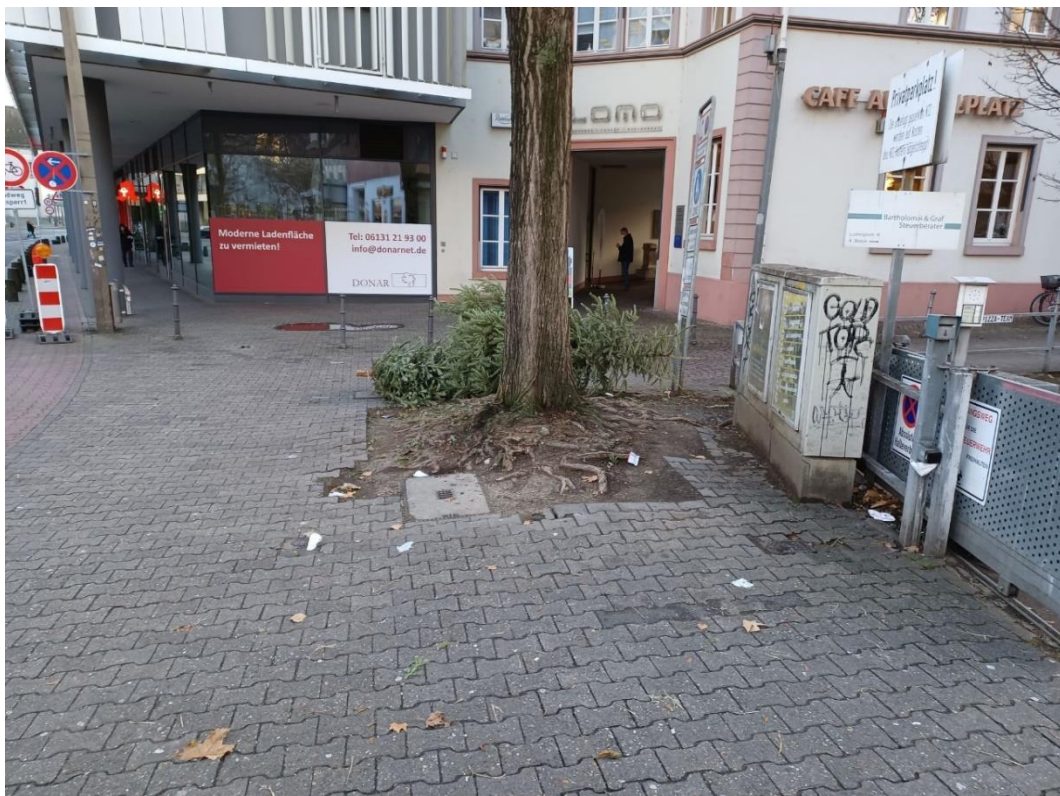
Abb. 46: Weißliliegasse, Baum 16. Baumumfeld mit offenliegenden Wurzeln und Bodenaufwölbungen.
