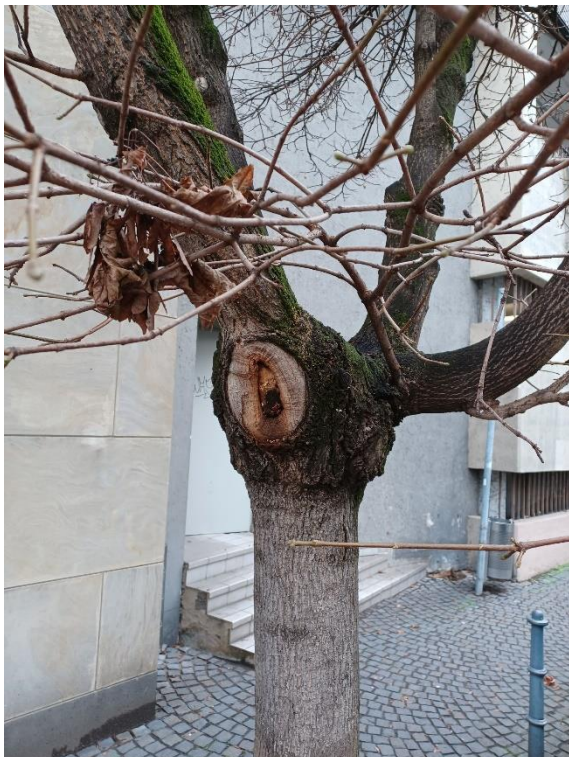
Abb. 40: Eppichmauergasse, Baum 15. Kappingsstelle mit Fäulnis.
