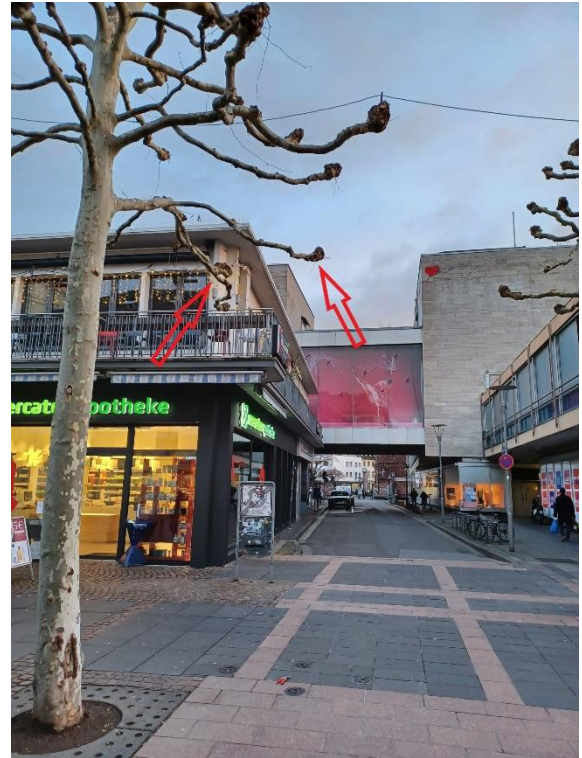
Abb. 74: Ludwigsstraße, Baum 41. Zu geringer lichter Raum vor Einfahrt Baustraße.
