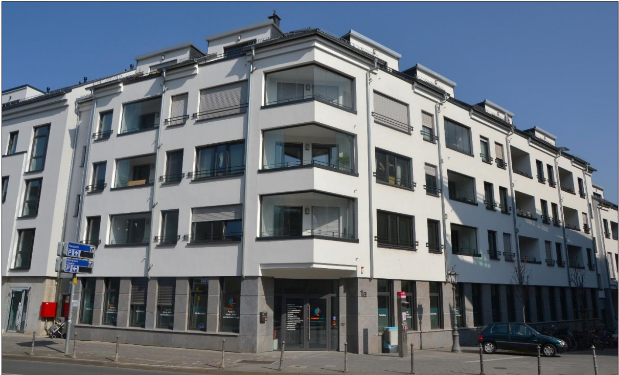
Abbildung 12: Projekt „Umstrukturierung des ehemaligen Caritashauses“ (Q10) nach Fertigstellung (© Landeshauptstadt Mainz)
