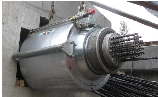
Vorrichtung zum Spannen des Spannstahls
