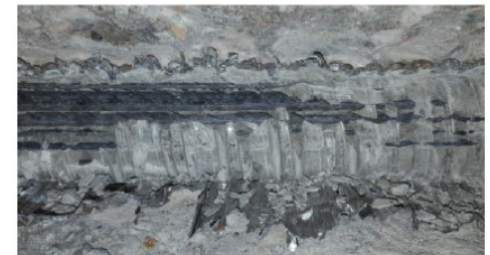
Hüllrohr geöffnet mit Drähten (St 145/160 „Sigma-Oval“)
