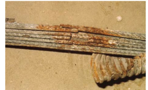
Drahtbündel aus Schadensfall (Nünberger et. al. 1994)
