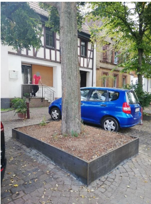
Gänsmarkt - Erste sanierte Baumscheibe in Cortenstahl 2021
