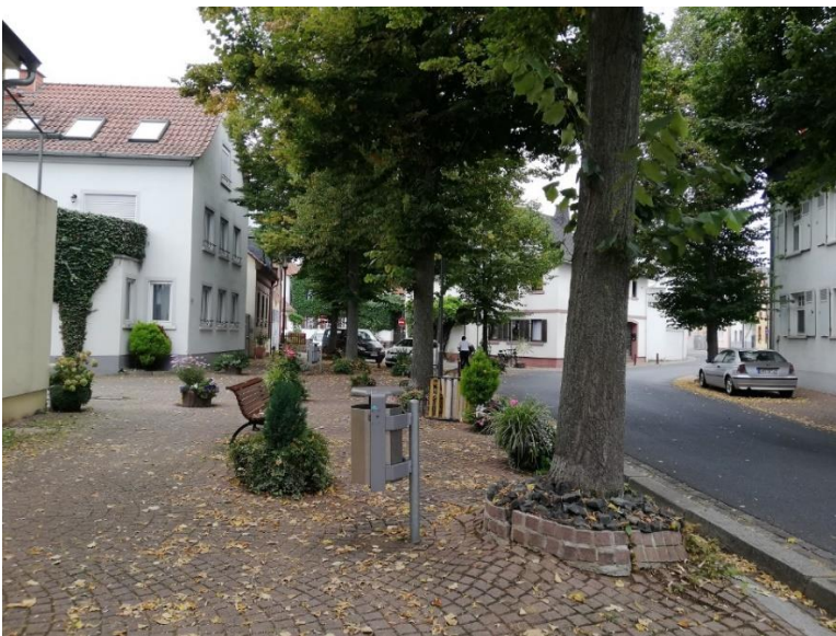
Bestandssituation Gänsmarkt - Baumscheiben mit maroden Betonpflasteraufkantungen
