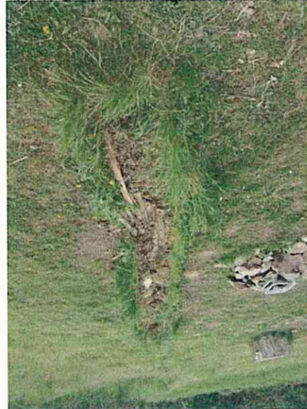
Vandalismus – entfernte Sitzgelegenheit
