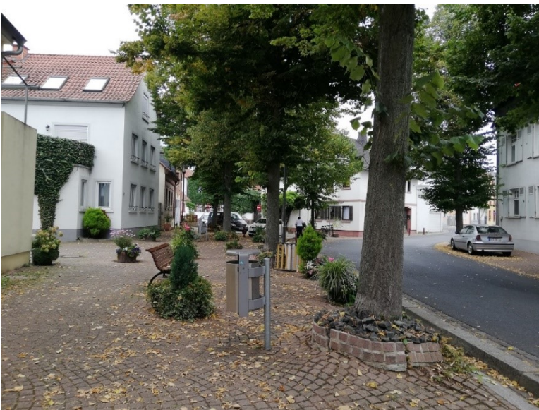
Bestandssituation Gänsmarkt - Baumscheiben mit maroden Betonpflasteraufkantungen
