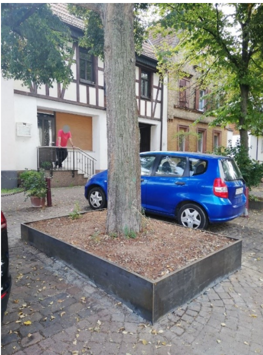
Gänsmarkt - Erste sanierte Baumscheibe in Cortenstahl 2021
